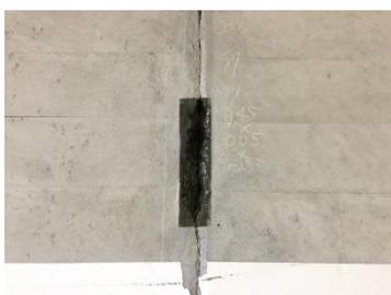
写真-3.3 はつり落とし工
