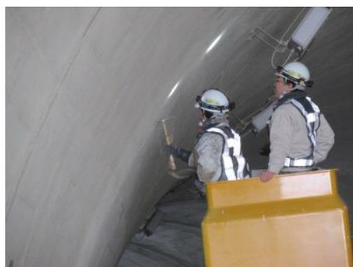
写真-3.2 打音検査
