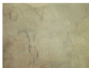
写真-2.2 うき(左：覆工、右：吹付)
