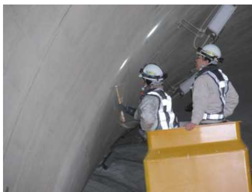
写真-3.2 打音検査
