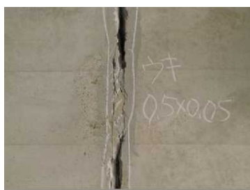
写真-2.2 うき(左：覆工、右：吹付)
