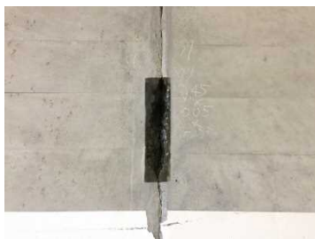
写真-3.3 はつり落とし工
