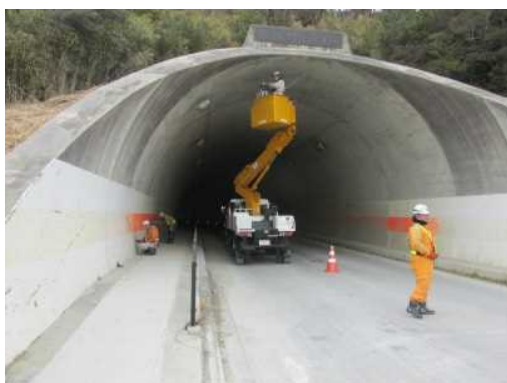
写真-3.1 近接目視点検
