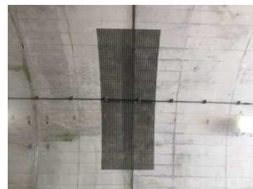
写真-3.4 ネット工
