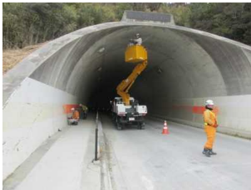
写真-3.1 近接目視点検
