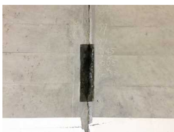
写真-3.3 はつり落とし工
