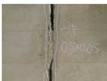
写真-2.2 うき(左：覆工、右：吹付)
