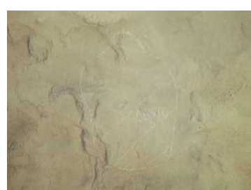
写真-2.2 うき(左：覆工、右：吹付)
