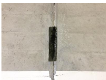
写真-3.3 はつり落とし工
