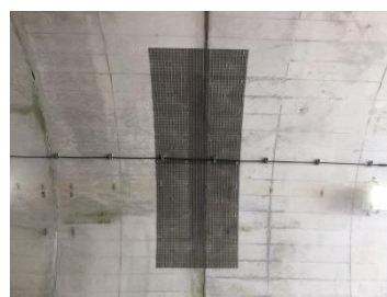
写真-3.4 ネット工
