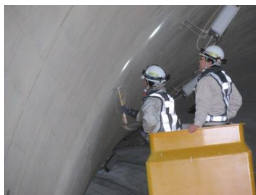
写真-3.2 打音検査
