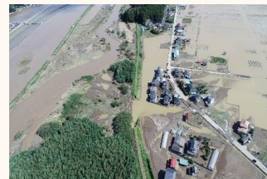
② ※県相双建設事務所より提供
