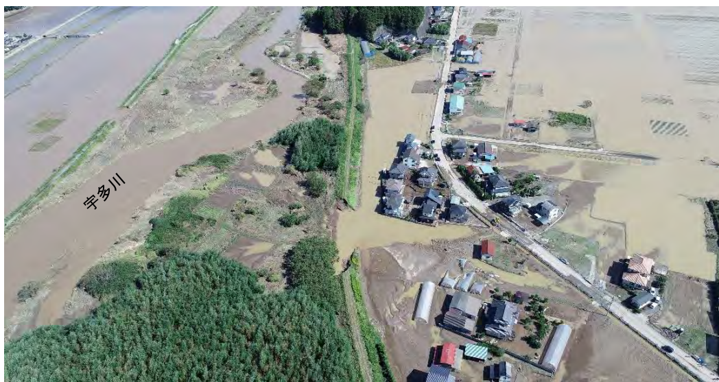
宇多川の破堤による浸水被害（河川右が南飯渕地区、岩子地区、河川左が北飯渕地区、和田地区） （写真提供：県相双建設事務所）
