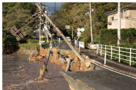
河川氾濫の状況（西山地区）
