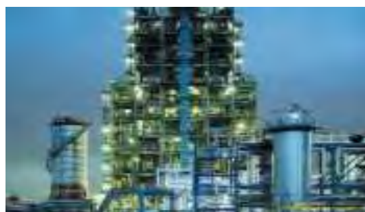
KPR (川崎プラスチックケミカルリサイクルプラント)
