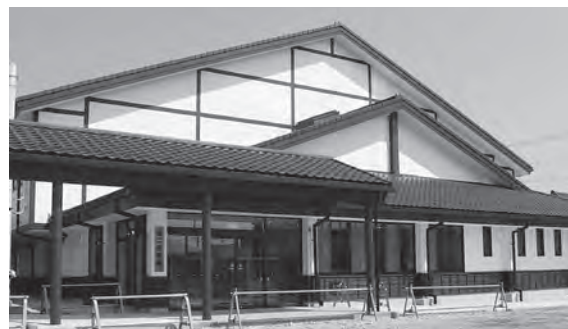
完成したスポーツアリーナそうま第二体育館
