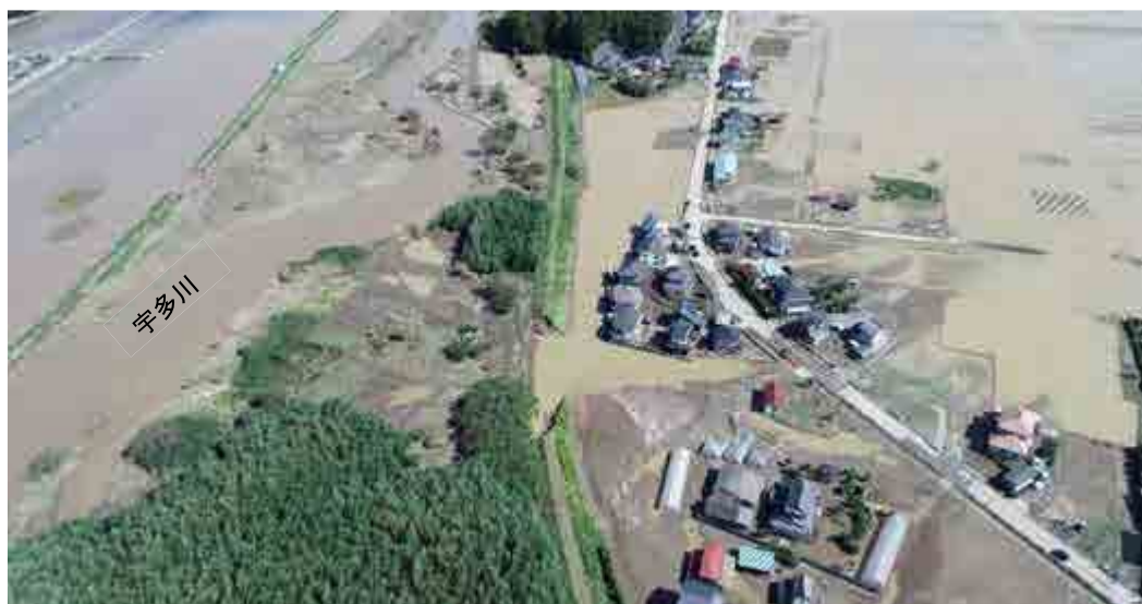
宇多川の破堤による浸水被害（河川右が南飯渕地区、岩子地区、河川左が北飯渕地区、和田地 （写真提供：県相双建設事務所）
