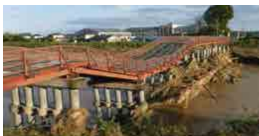
市道橋の崩壊（中橋）
