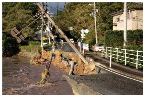
河川氾濫の状況（西山地区）
