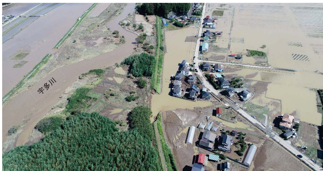
宇多川の破堤による浸水被害（河川右が南飯渕地区、岩子地区、河川左が北飯渕地区、和田地 （写真提供：県相双建設事務所）
