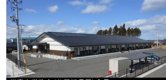
災害市営住宅(井戸端長屋)全景 平成27年3月24日撮影
