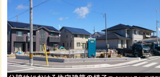
分譲地における住宅建築の様子 平成27年3月24日撮影
