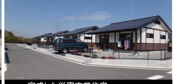
完成した災害市営住宅 平成27年4月23日撮影
