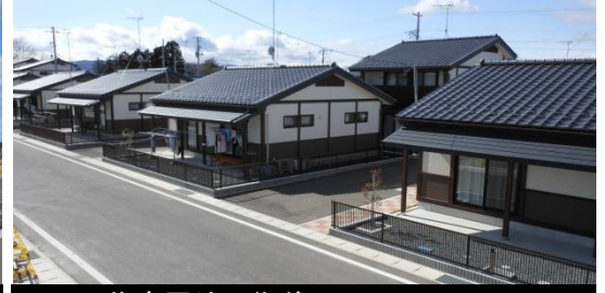
住宅団地の街並み 平成27年3月24日撮影
