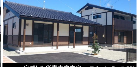
完成した災害市営住宅 平成27年3月24日撮影
