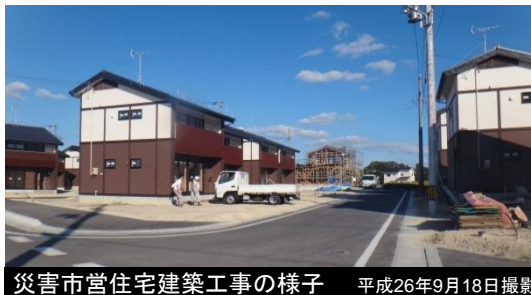
災害市営住宅建築工事の様子 平成26年9月18日撮影
