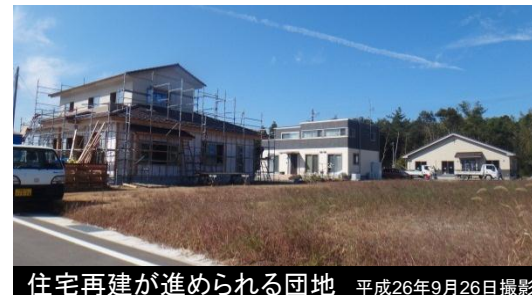
住宅再建が進められる団地 平成26年9月26日撮影
