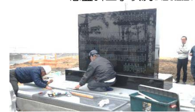
慰霊碑工事状況(H26.2.27)
