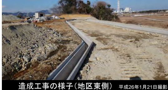
造成工事の様子(地区東側) 平成26年1月21日撮影
