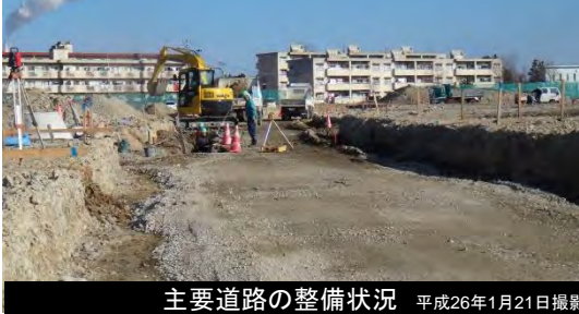
主要道路の整備状況 平成26年1月21日撮影
