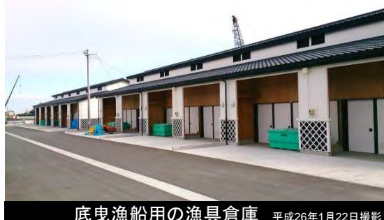
底曳漁船用の漁具倉庫 平成26年1月22日撮影
