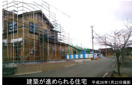
建築が進められる住宅 平成26年1月22日撮影
