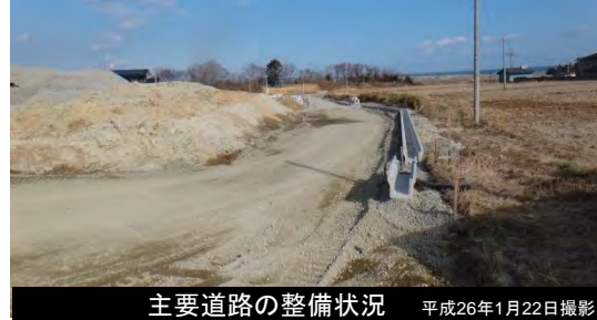
主要道路の整備状況 平成26年1月22日撮影
