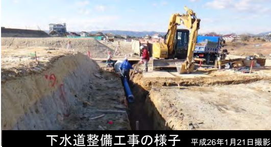
下水道整備工事の様子 平成26年1月21日撮影
