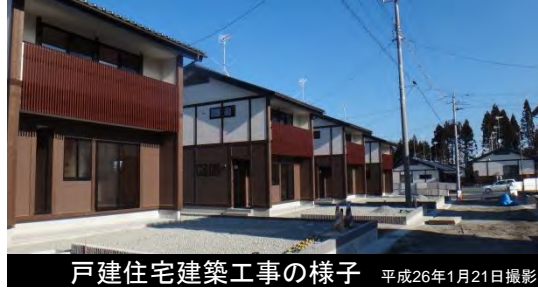
戸建住宅建築工事の様子 平成26年1月21日撮影
