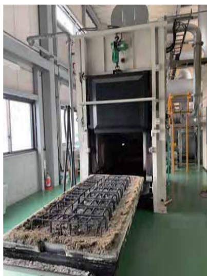
有害鳥獣焼却場施設内
