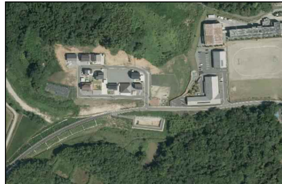
団地造成後(平成 30 年)
