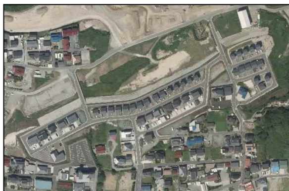
団地造成後(平成 30 年)
