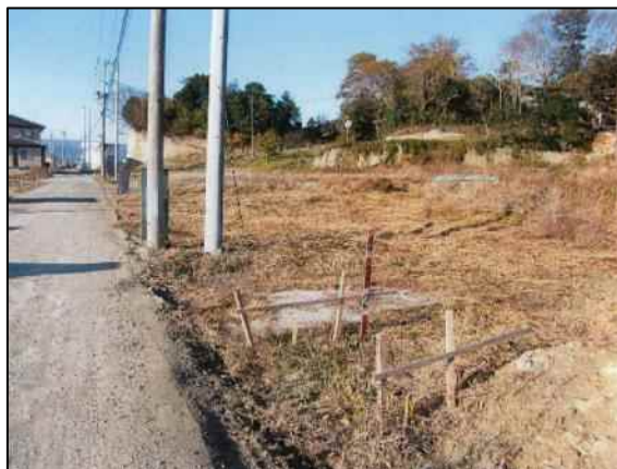
道路嵩上箇所背後地盛土（施工前）
