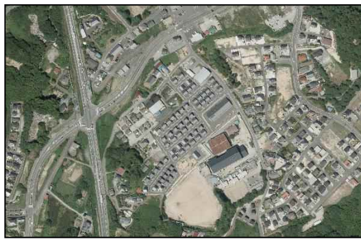
団地造成後(平成30年)
