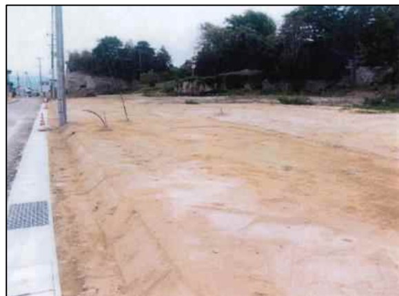
道路嵩上箇所背後地盛土（施工後）
