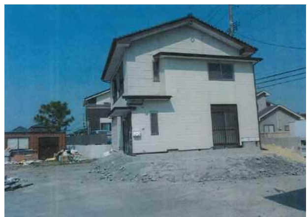
物件移転補償（施工後）
