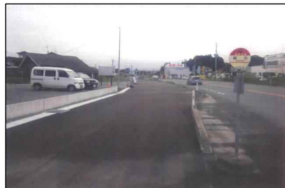
雨水幹線（施工後）
