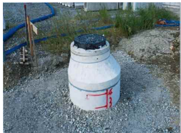
マンホール嵩上（施工後）
