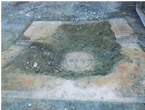
マンホール嵩上（施工前）
