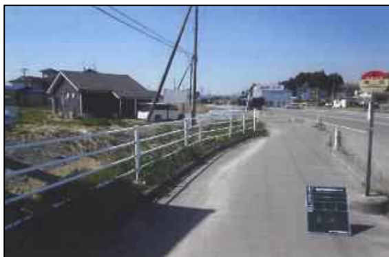
雨水幹線（施工前）
