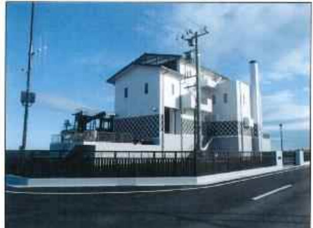
松川ポンプ場（整備後）
