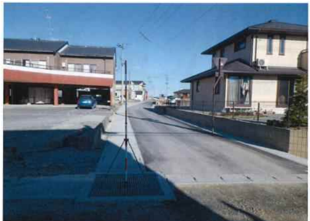
雨水幹線（施工後）
