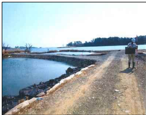
細田ポンプ場（整備前）
