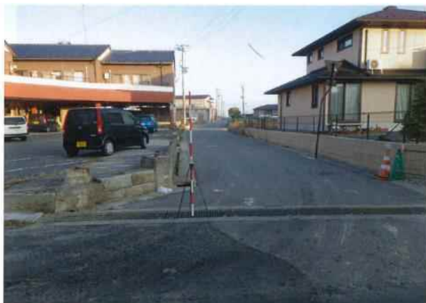
雨水幹線（施工前）
