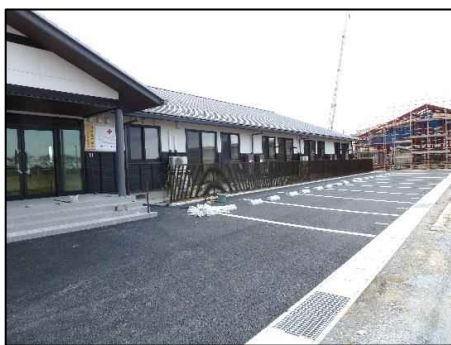
駐車場（磯部狐穴団地）
