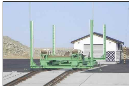
磯部上架施設（整備後）
