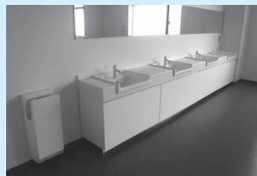
相馬市役所新庁舎 新築工事
