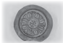
【軒丸瓦】 屋根の先端に使う装飾のついた瓦です。
