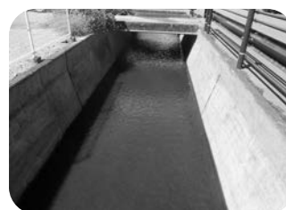
正常な都市下水路
