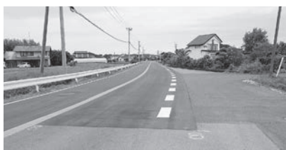
舗装修繕した市道の様子(南飯渚地内)
