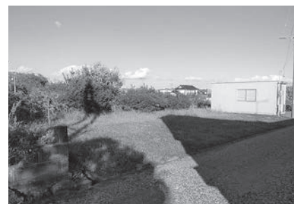
2. 赤木字新堤の現況写真
