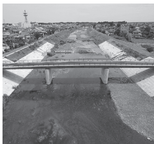
復旧した中橋
