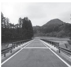
復旧した茄子小田橋
