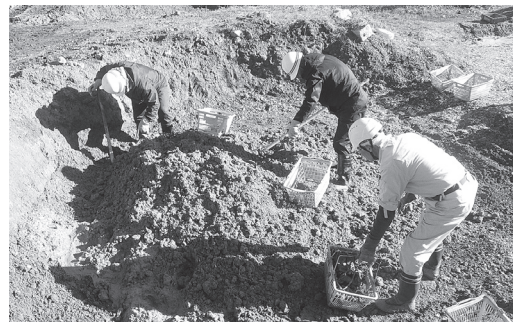
埋め立て前に金属などを選別 (一般廃棄物埋立処分場)
