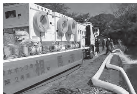
排水ポンプ車訓練
