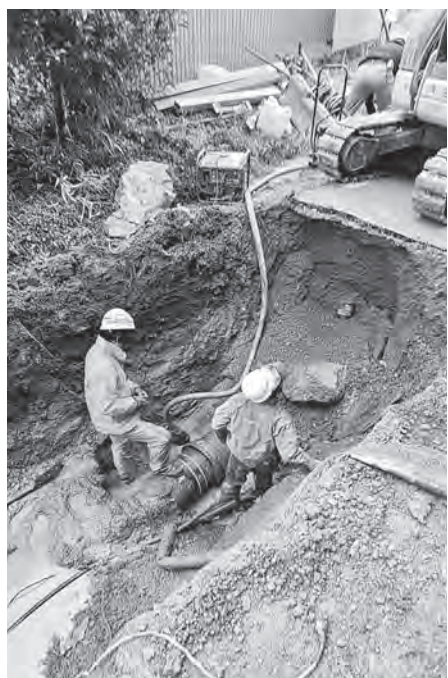
水道管の修繕工事（水道企業団）
