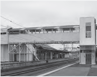
JR相馬駅に設置されたエレベーター
