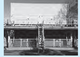
小泉川ポンプ場
