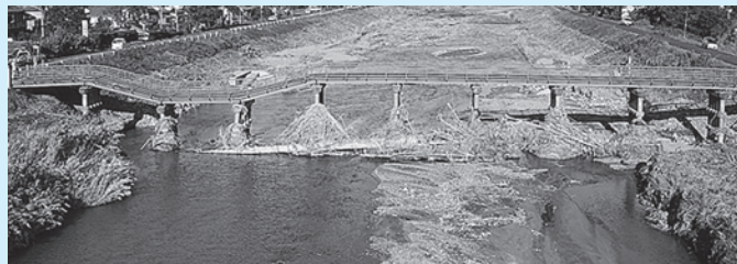
被災した中橋
