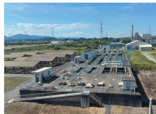
下水処理場の水処理施設
