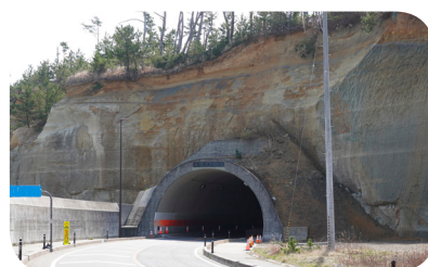
鵜ノ尾崎トンネル坑口 (3月27日時点)
