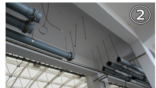
被害を受けた原釜荷捌き施設の写真 ①内壁(右上)、②海水送水管(右下)、③外階段(上)
