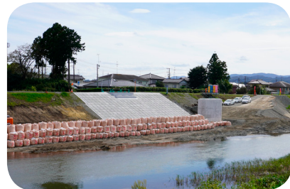
工事中の中橋（9月30日時点）
