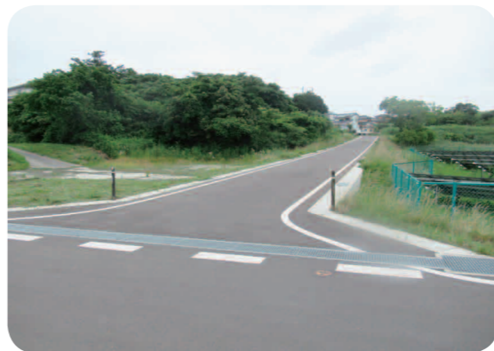
避難道路の整備が完了したことにより認定する市道東部86号線 (原釜地内)
