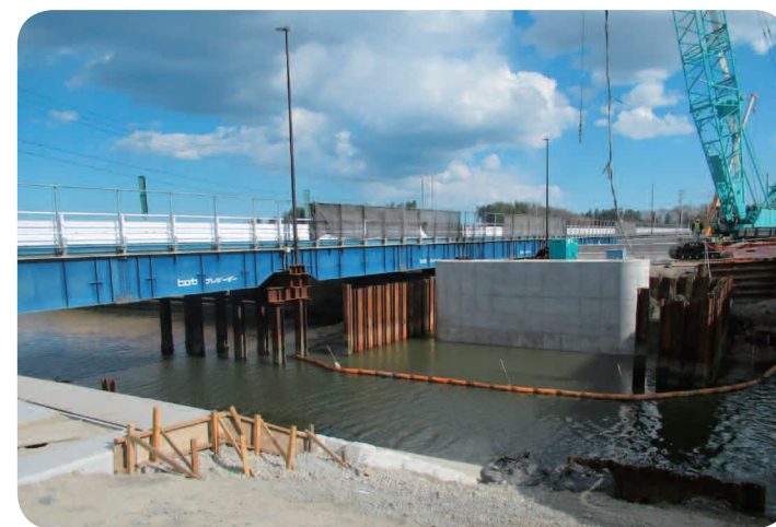
百間橋の架け替え工事
