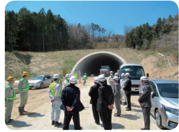
塩手山トンネル工事の進捗状況を確認する委員ら
