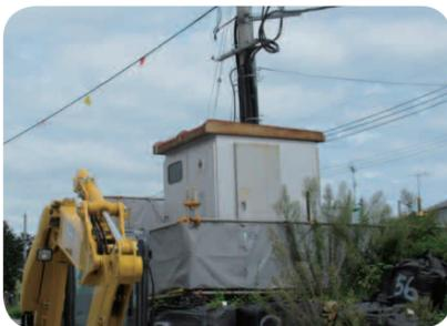
新たな設備が設置された後、解体される予定の高圧受電設備
