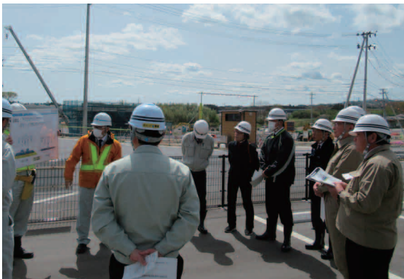
相馬市バスターミナルから相馬IC付近の 工事進捗状況について説明を受ける委員ら
