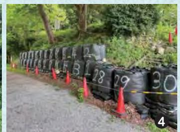
東日本大震災後、石垣 (石積み) の積み直しを行うために、発掘調査などを実施しましたが、2 ヶ年にわたり発災した福島県沖地震により、さらに被害が拡大しました。現在は、大手門を復旧し、石垣の危険個所には防護ネットや大型土嚢を配置しています。今後、石垣の状況を確認しながら、復旧方法を順次検討します。
