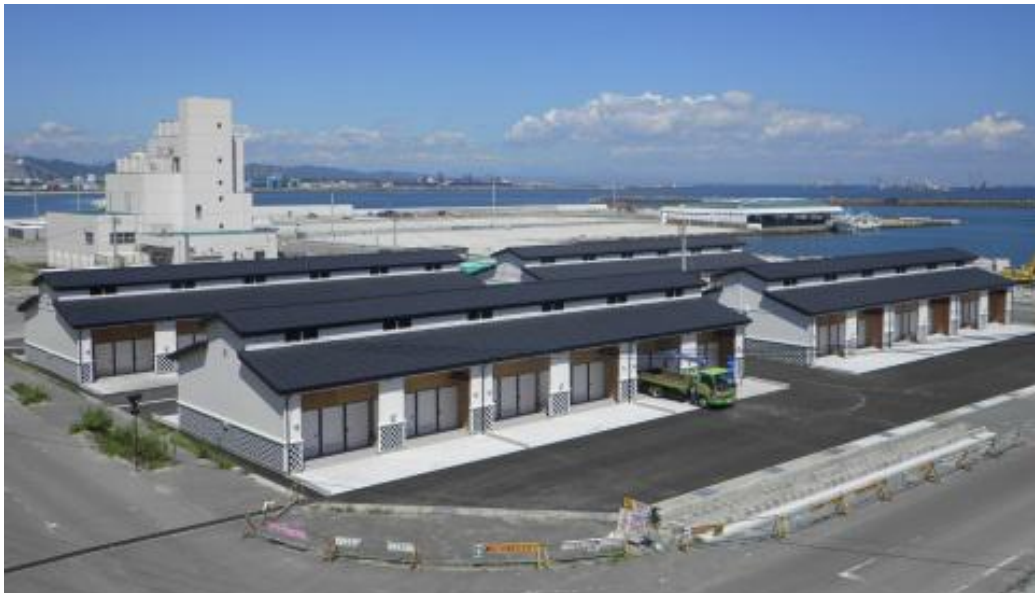
越屋根（漁具倉庫）
