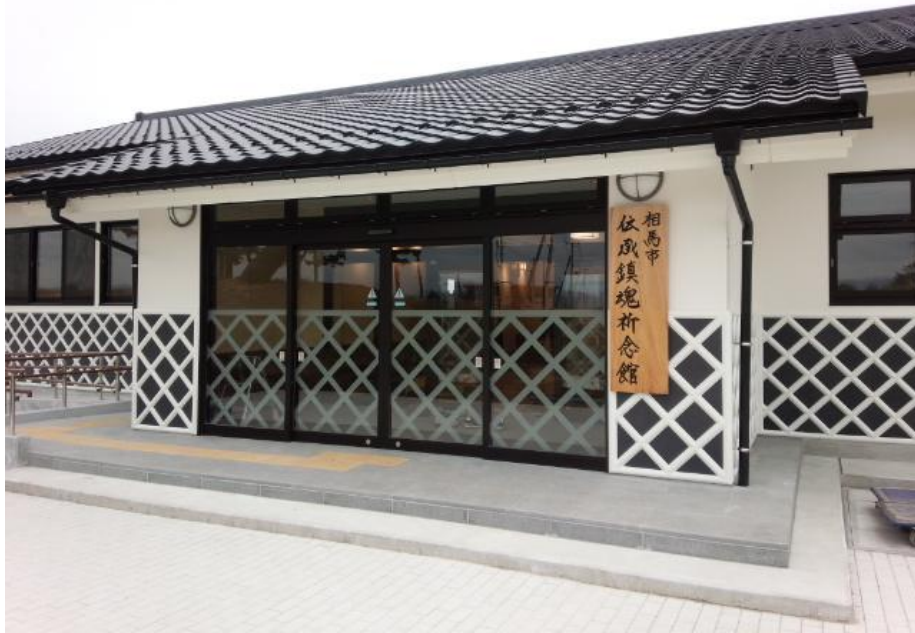
腰壁（なまこ壁） （伝承鎮魂祈念館）
