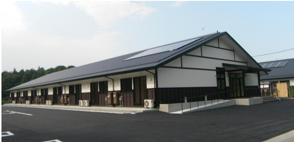
切妻屋根（井戸端長屋）
