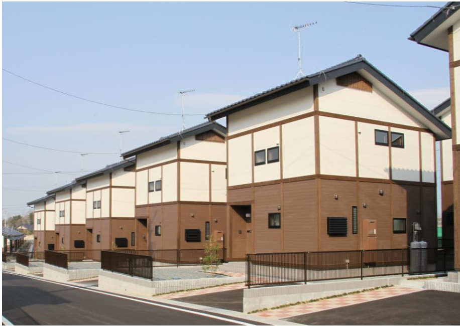
腰壁 及び 付柱・付梁 (細田東団地災害公営住宅)
