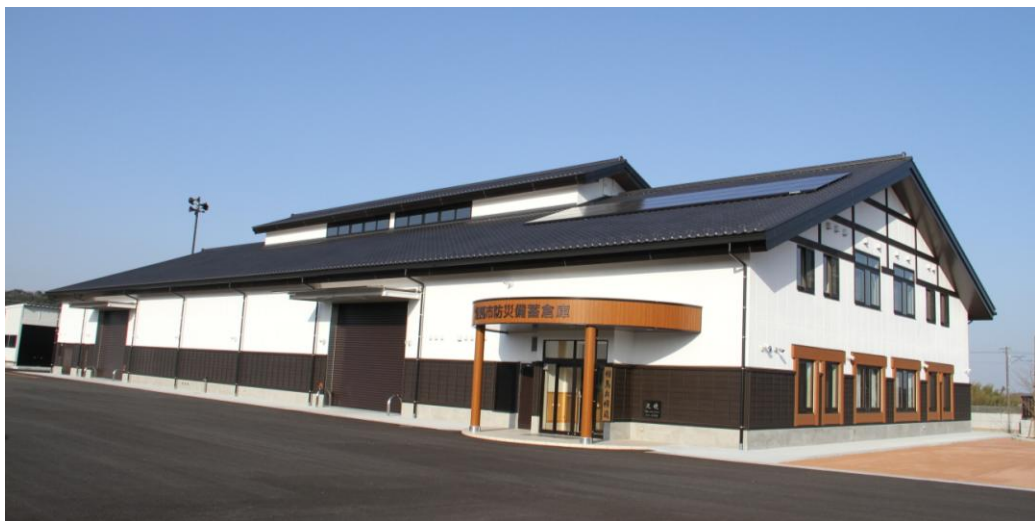
越屋根（防災備蓄倉庫）
