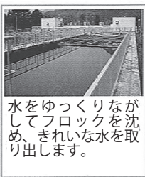
④ 薬品沈殿池
