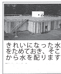
⑥ 浄配水池
