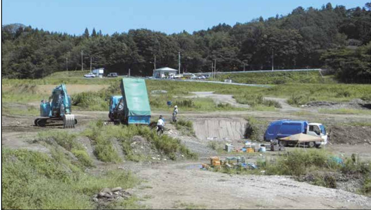
一般廃棄物埋立処分場（相馬市磯部地内）で、燃やすごみの焼却処理により発生した灰を埋め立てしている様子。
